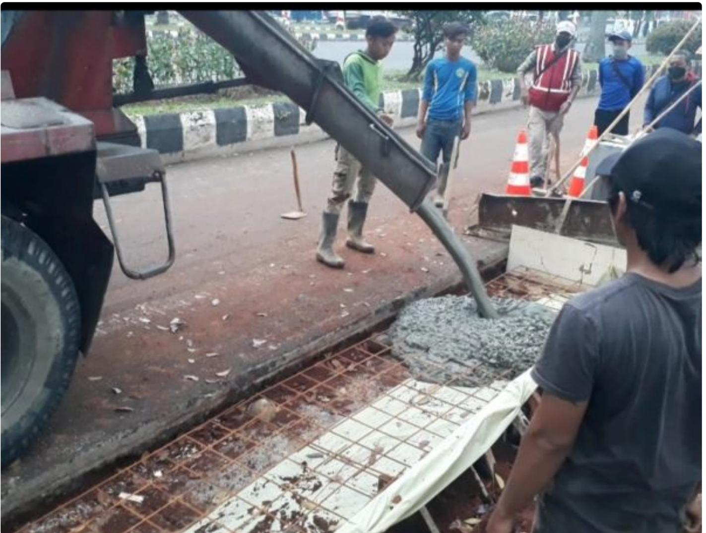
*(Foto dok: Saat pengecoran kondisi plastik coran kotor dan tidak ada decking beton)*
